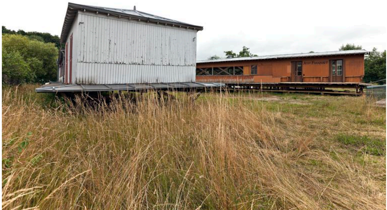
Le Saint-Yves en 2013. Superstructure, pavillon aval, vue de détail : pignon.
