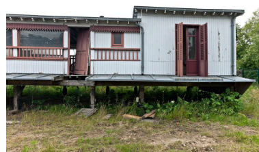
Le Saint-Yves en 2013. Superstructure, vue de détail : extrémité de la partie centrale et pavillon amont. Phot. Yves Guillotin IVR52_20135300671NUCA
