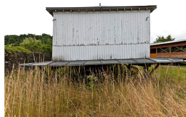
Le Saint-Yves en 2013. Superstructure, pavillon aval, vue de détail : pignon. Phot. Yves Guillotin IVR52_20135300667NUCA
