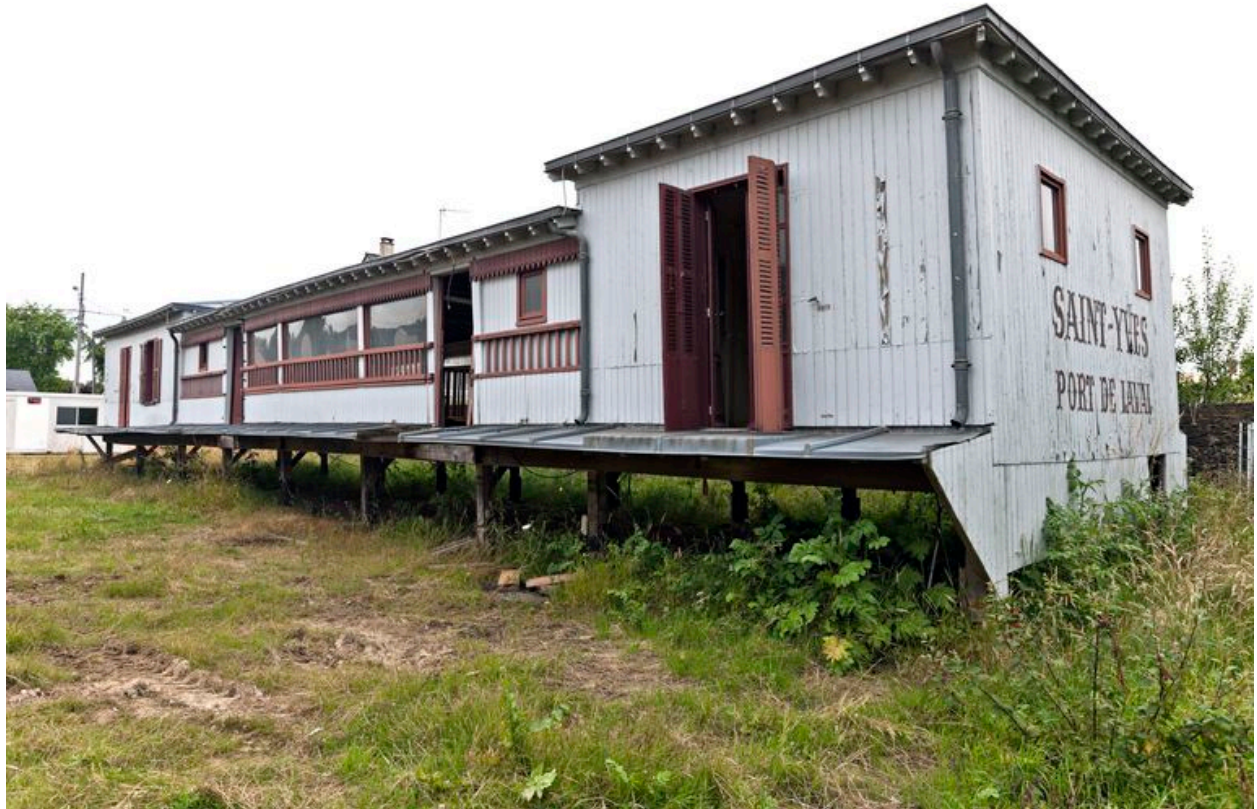
Le Saint-Yves en 2013. Superstructure, façades antérieures : vue d'ensemble.
