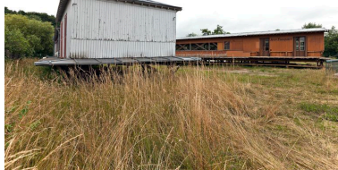
Le Saint-Yves en 2013. Superstructure, pavillon aval, vue de détail : pignon. Phot. Yves Guillotin IVR52_20135300668NUCA
