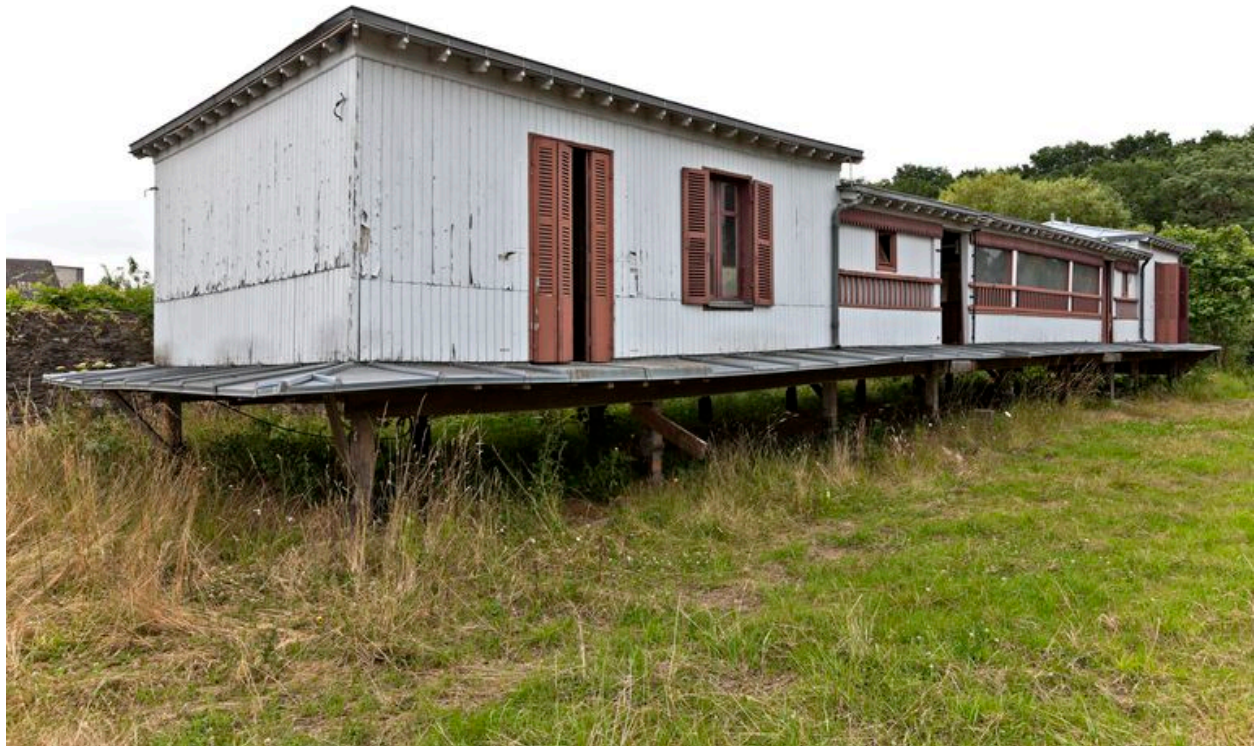
Le Saint-Yves en 2013. Superstructure, façades antérieures : vue d'ensemble.
