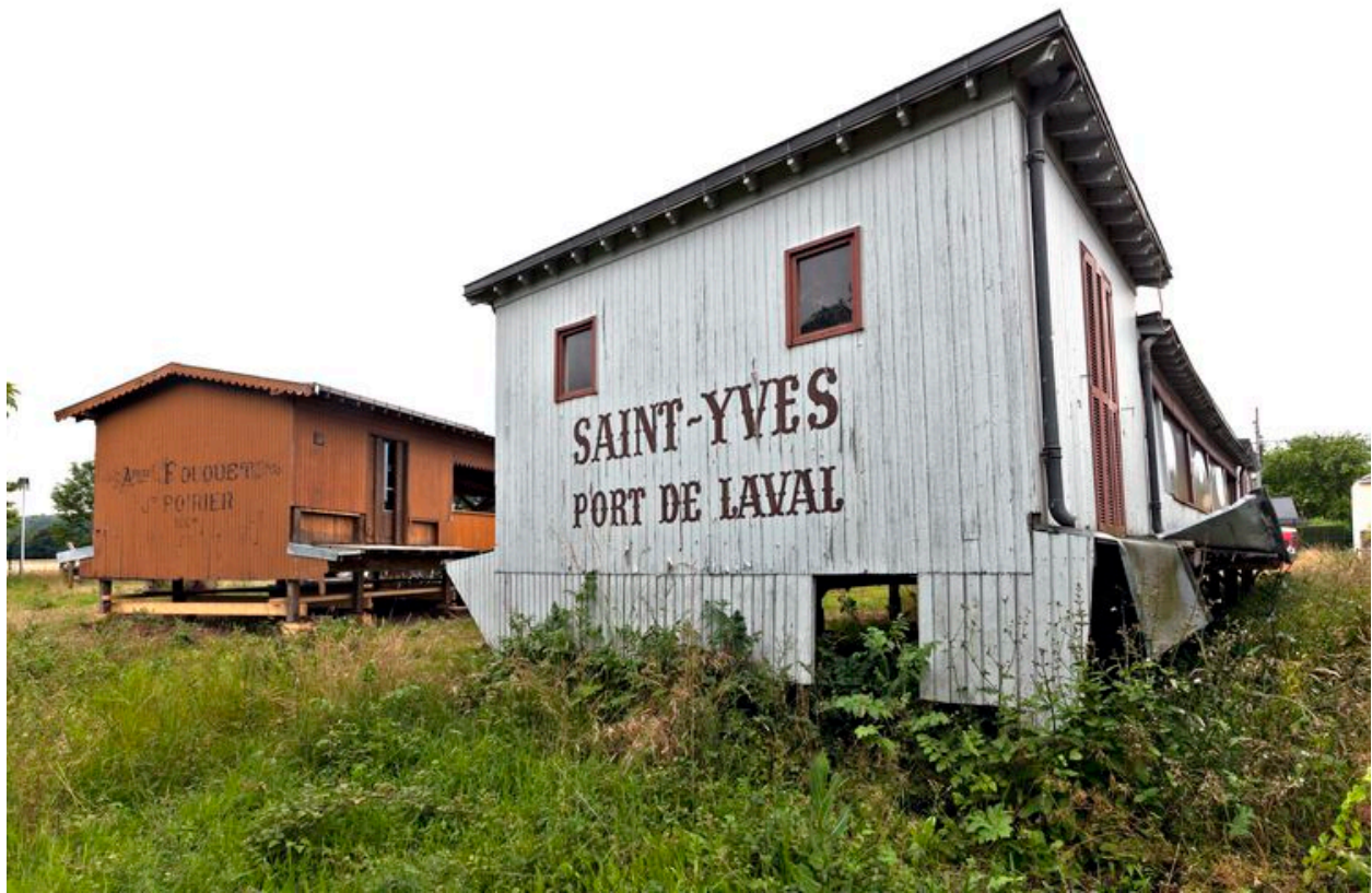
Le Saint-Yves en 2013. Superstructure, pavillon amont, vue de détail : pignon.
