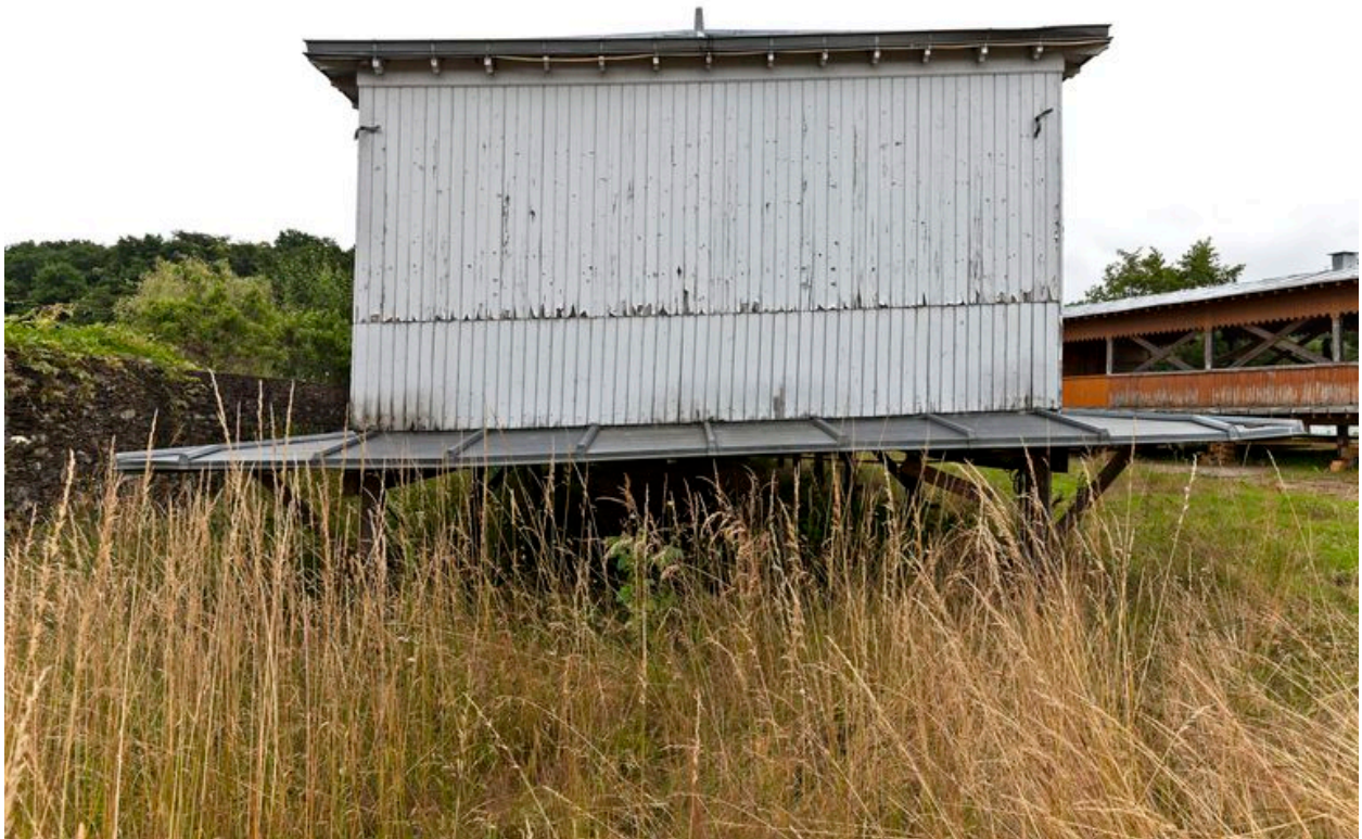
Le Saint-Yves en 2013. Superstructure, pavillon aval, vue de détail : pignon.
