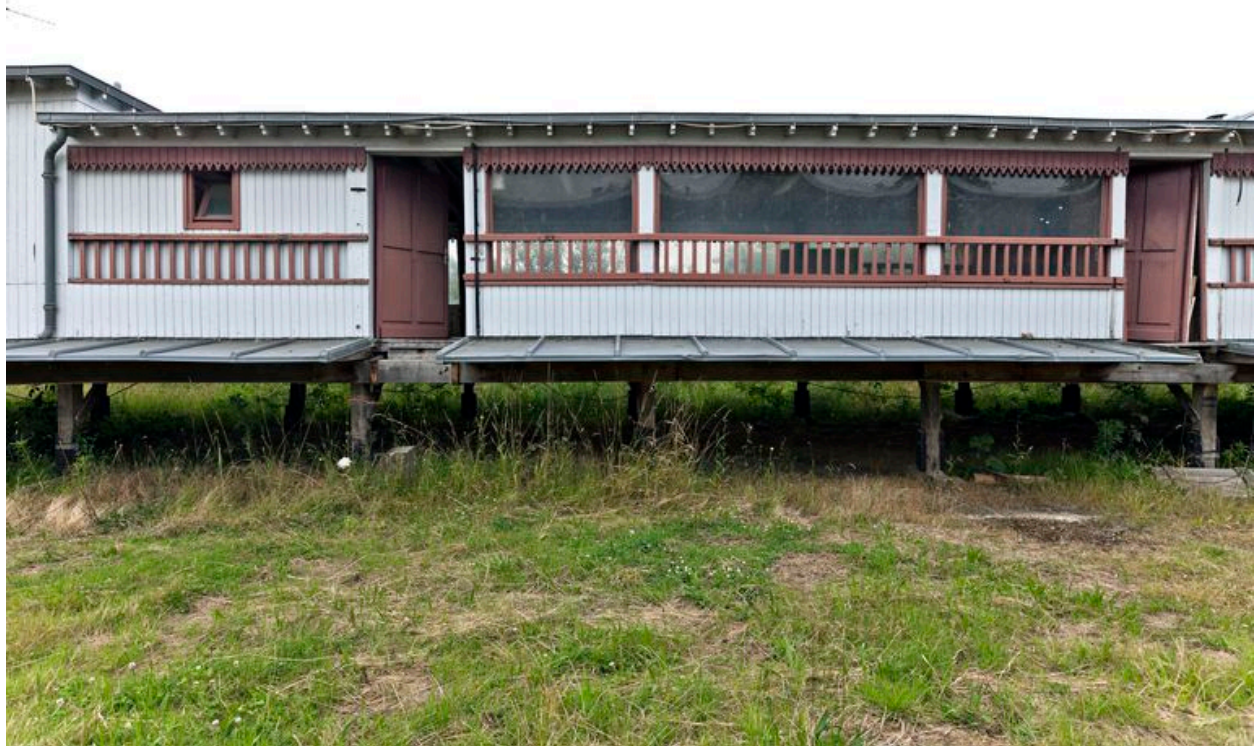
Le Saint-Yves en 2013. Superstructure, partie centrale : vue d'ensemble.
