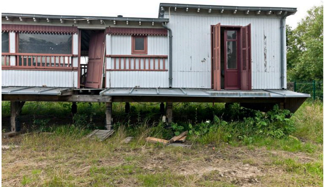
Le Saint-Yves en 2013. Superstructure, vue de détail : extrémité de la partie centale et pavillon amont.
