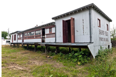
Le Saint-Yves en 2013. Superstructure, façades antérieures : vue d'ensemble. Phot. Yves Guillotin IVR52_20135300658NUCA
