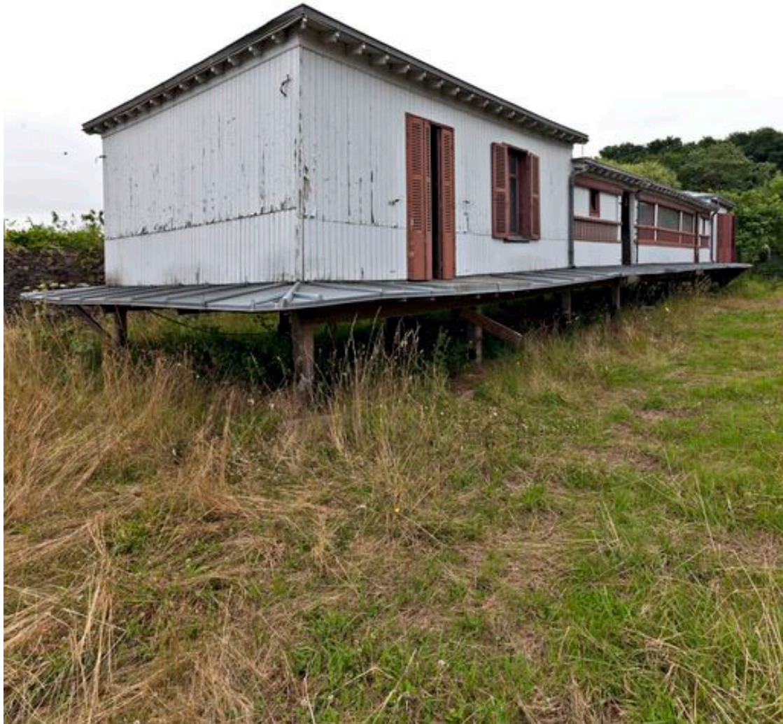
Le Saint-Yves en 2013. Superstructure, façades antérieures : vue d'ensemble.
