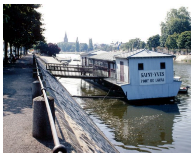
Vue d'ensemble vers l'aval. Phot. François Lasa IVR52_19885300323XA
