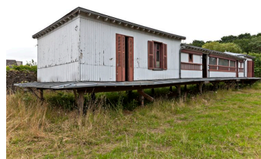
Le Saint-Yves en 2013. Superstructure, façades antérieures : vue d'ensemble. Phot. Yves Guillotin IVR52_20135300666NUCA
