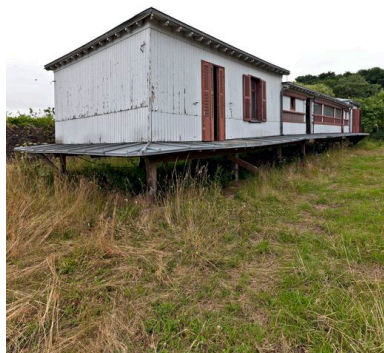
Le Saint-Yves en 2013. Superstructure, façades antérieures : vue d'ensemble. Phot. Yves Guillotin IVR52_20135300669NUCA
